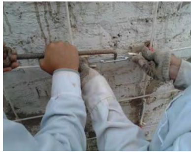
(a) Tensado de cuerdas mediante templadores
