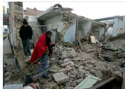
Figura 1.2. Destrucción de casas de adobe por eventos sísmicos
