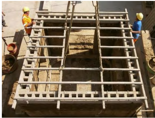
(a) Estructura de madera del techo
