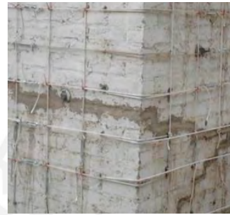
(b) Cuerdas horizontales en contacto con adobe y mortero
