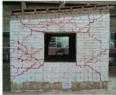
(b) Muro longitudinal izquierdo
