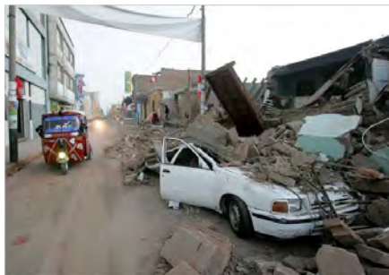
Figura 1.3. Colapso de viviendas de adobe en Ica (2007)
