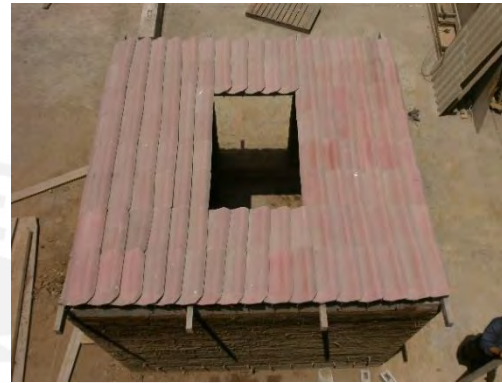
(b) Cobertura de tejas del techo
