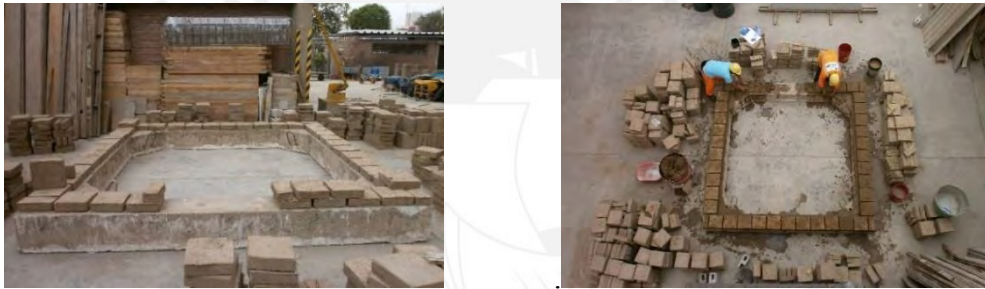
(a) Emplantillado sobre cimentación (b) Primera hilada sobre base de mortero
