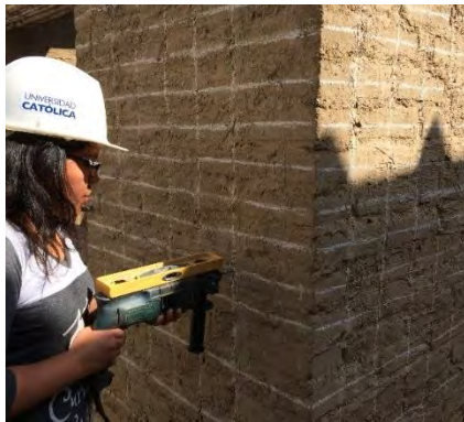
(a) Perforación con nivel de mano
