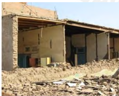
(a) Volteo muro solo
