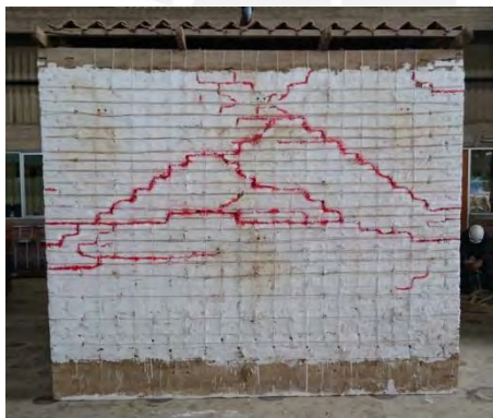
(c) Muro transversal posterior
