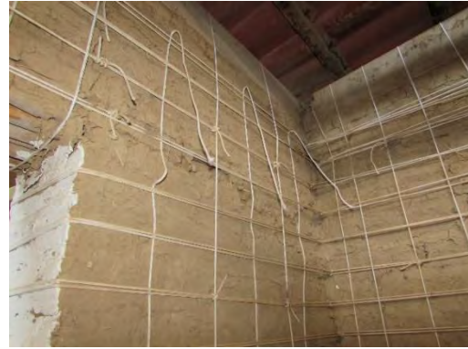
(b) Cuerdas de refuerzo vertical rotas
