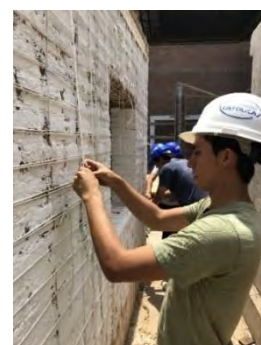
(b) Tensado de nudo
