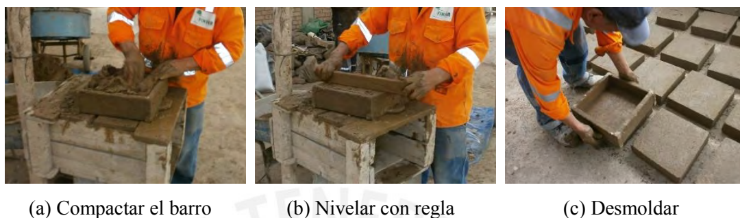
Figura 3.4. Proceso de elaboración de unidades de adobes
