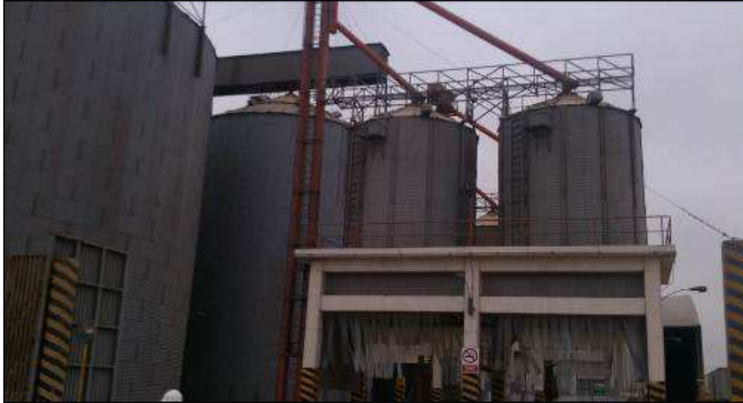
Figura 2.4 Silos y Silos Despachadores (pulmones)
