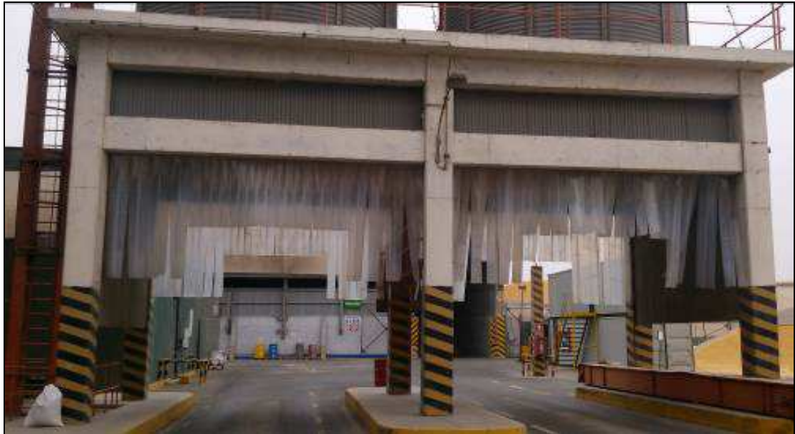
Figura 2.5 Zona de despacho (Silos) Fuente: La Empresa
