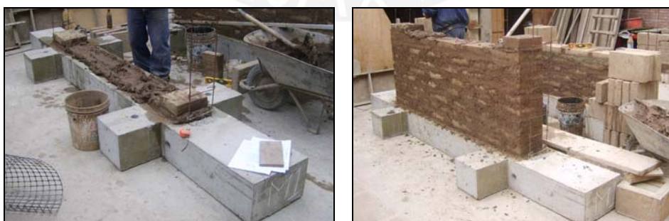
Fig. 4.6. Secuencia de construcción de los Muros M1 y M2
