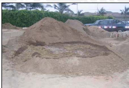
Fig. 2.5. Proceso de "dormir la tierra"
