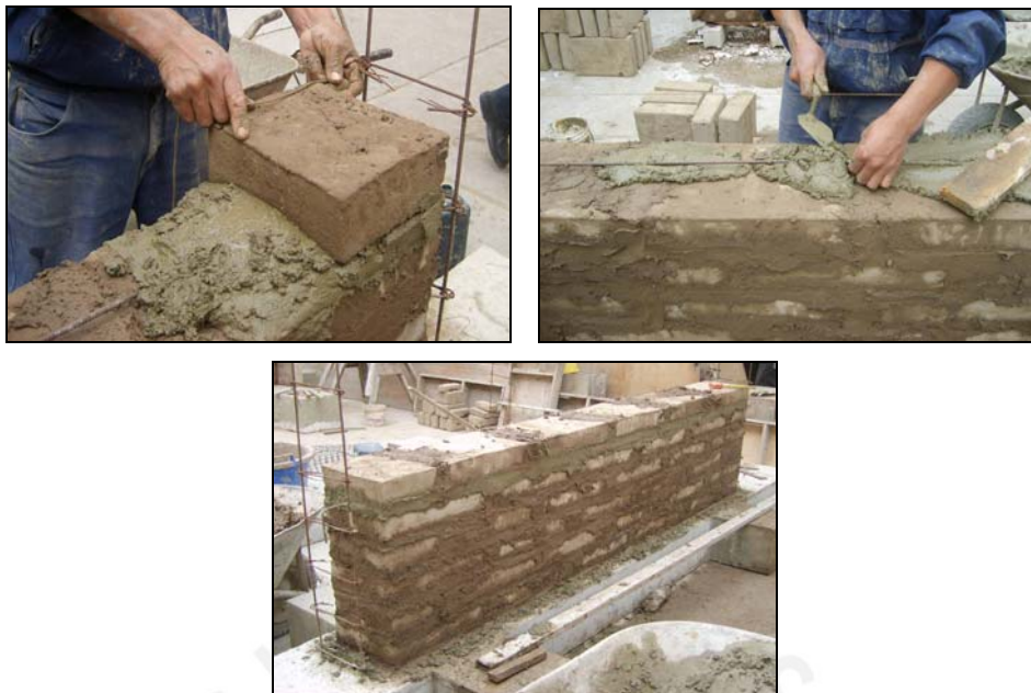
Fig. 4.7. Refuerzo horizontal en el muro M2 y mortero de cemento.
