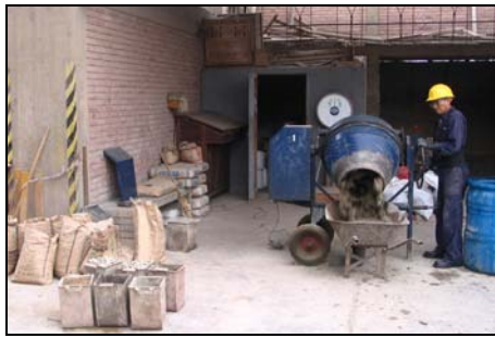
Fig. 3.7. Preparación de concreto.
