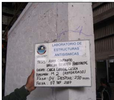
Fig.5.24. Fisuración de columna derecha.
