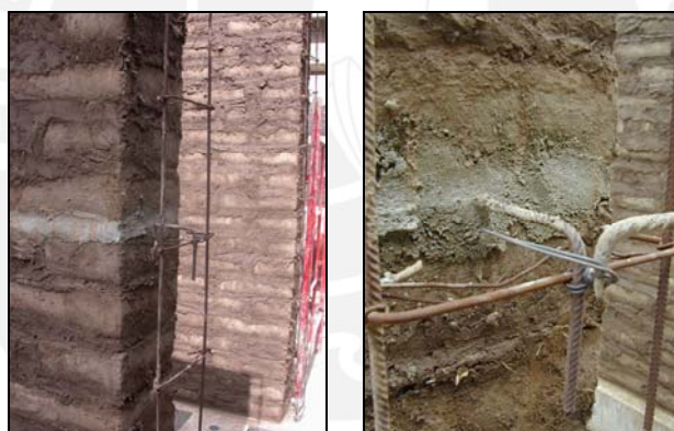
Fig. 4.8. Anclaje del refuerzo horizontal del muro M2 amarrado al estribo de la columna.
