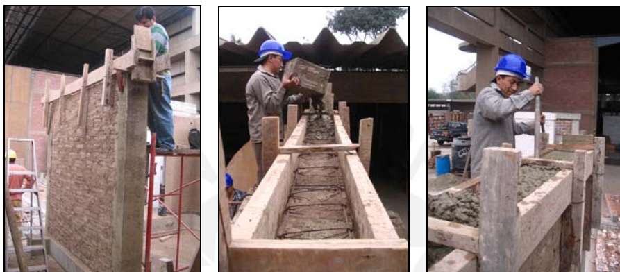
Fig. 4.11. Secuencia del proceso constructivo empleado en las soleras
