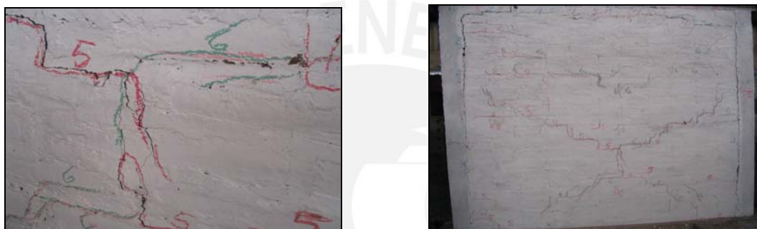
Fig.5.12. Formación de nuevas fisuras diagonales, grosor máximo 3mm.
