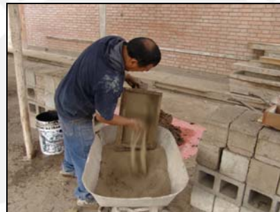
Fig. 2.7. Arenado de la adobera con arena fina
