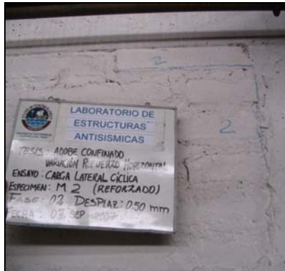
Fig. 5.18. Primera fisura área superior derecha del muro.
