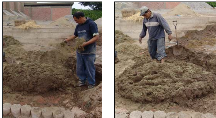
Fig. 2.6. Combinación de materiales proporción Volumétrica 3:1:1 y mezclado "pisoteando"
