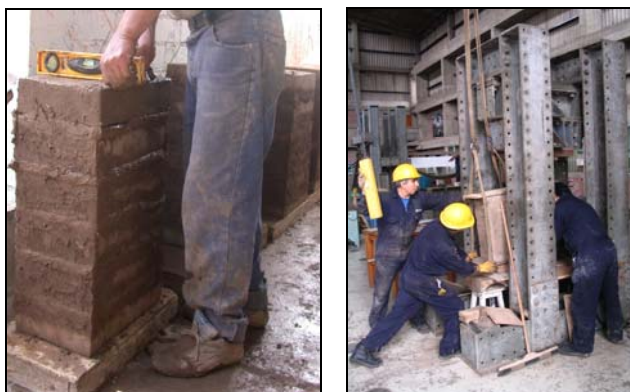
Fig. 3.5 Construcción y montaje de la pila.
