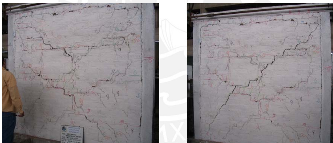
Foto 5.17. Grietas al aplicar desplazamientos positivos (izquierda) y negativos (derecha).
