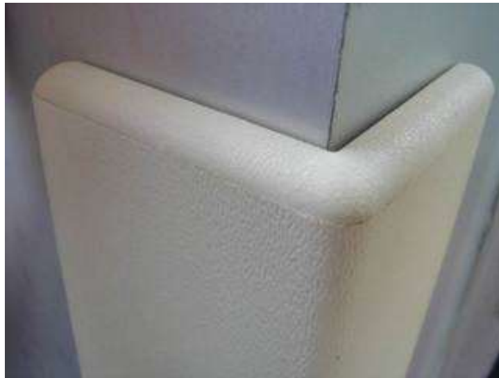
Imagen N° 43: Protección en esquinas
