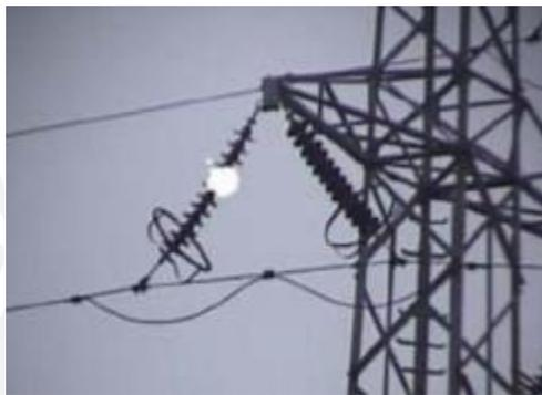
Fig. 4.7 Efecto corona producido en línea de transmisión [24]
