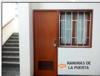
**Figura 3.2: Fachada del lugar de trabajo 1A, donde se puede visualizar unas ranuras que sirven como medio de ventilación, ubicadas en la parte inferior de la puerta de ingreso.**
