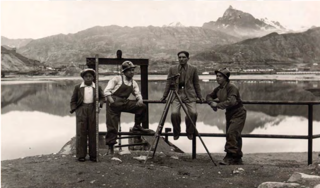
FOTO # 05 Trabajo topográfico realizado por personal de la empresa Cerro de Pasco
