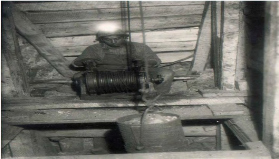
FOTO # 08 Maquinista moviendo materiales al interior de un socavón
