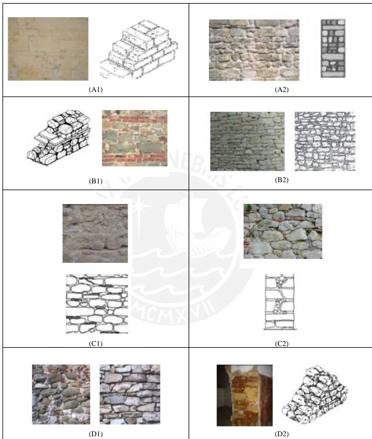
Figura 3.8: Ejemplos de albañilería de Piedra para las categorías A, B, C y D (Vicente; 2008)
