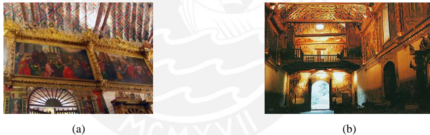
Figura 4. 5: Representación de los elementos no estructurales de Iglesia San Pedro Apóstol (a) Pormenor de los cuadros; (b) Vista interior en dirección a la fachada principal
