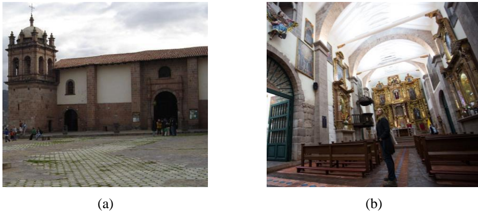
Figura 3.5: Demostración del sobrecimiento en la Iglesia de San Cristóbal (a) Exterior; (b) Interior
