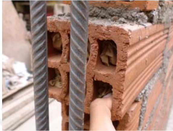
Figura 6.7. Taponado de ladrillos.
