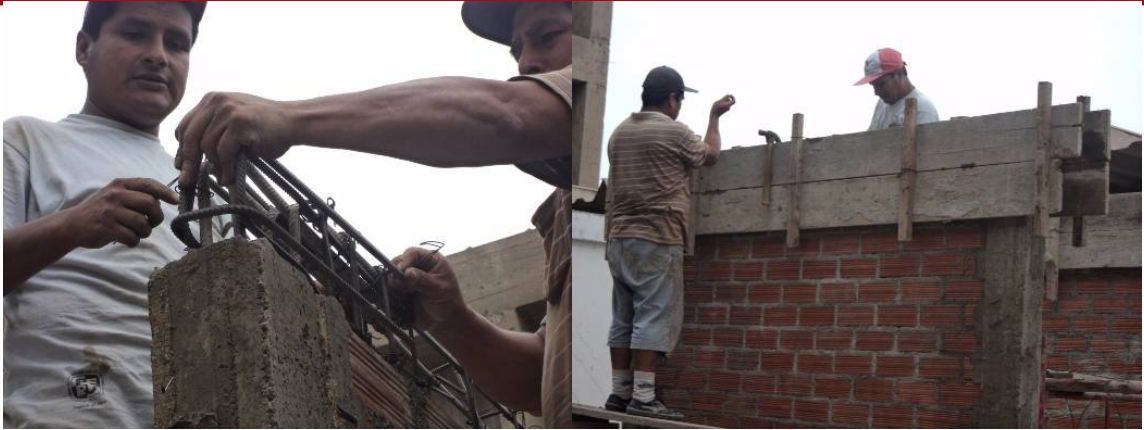
Figura 6.11. Colocación del refuerzo y encofrado de la viga solera.
