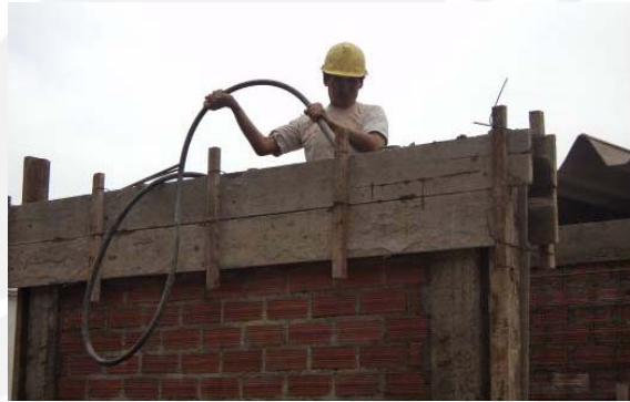
Figura 6.12. Vaciado de viga solera.
