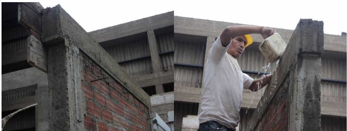
Figura 6.13. Desencofrado y curado de la viga solera.
