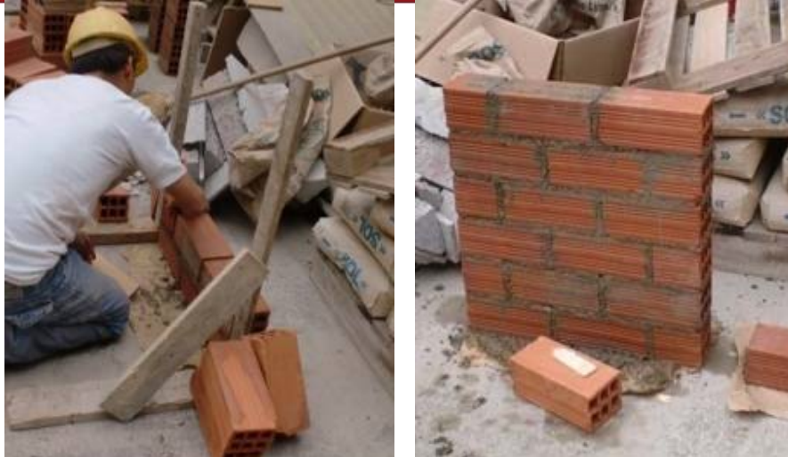
Figura 4.11. Construcción de Murete
