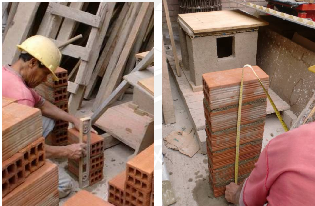
Figura 4.2. Construcción de pila
