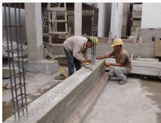
Figura 6.4. Limpieza de superficie y emplantillado para asentado de ladrillos.
