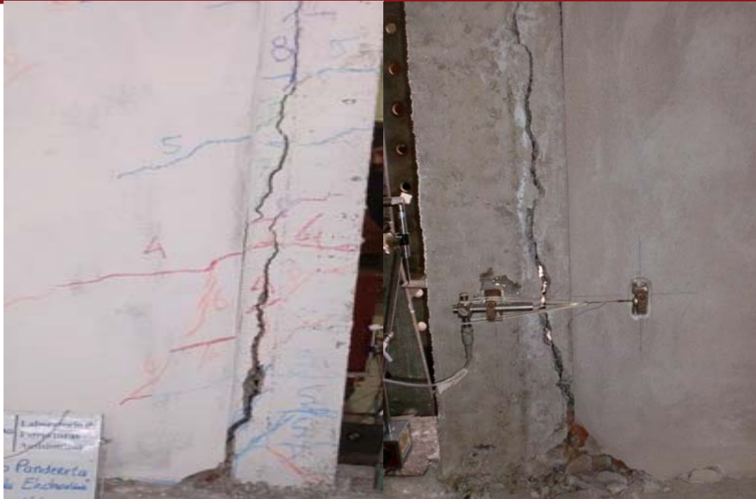
Figura 8.27. Trituración del concreto en columna izquierda, en ambas caras de M2.
