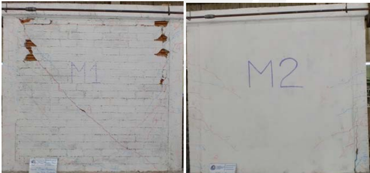
Figura 8.18. Izquierda, Muro Tradicional (M1) – Derecha, Muro enmallado (M2) – Fase 7
