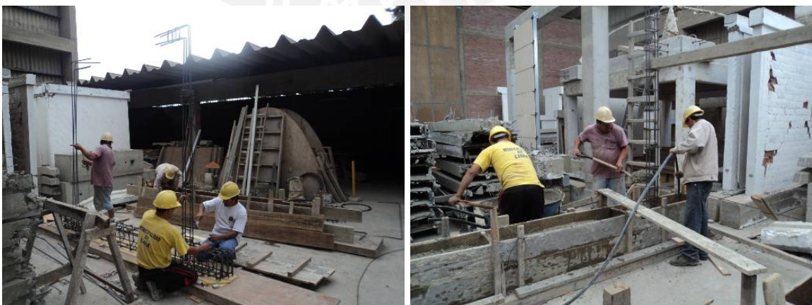
Figura 6.2. Colocación del acero y vaciado de la viga de cimentación.
