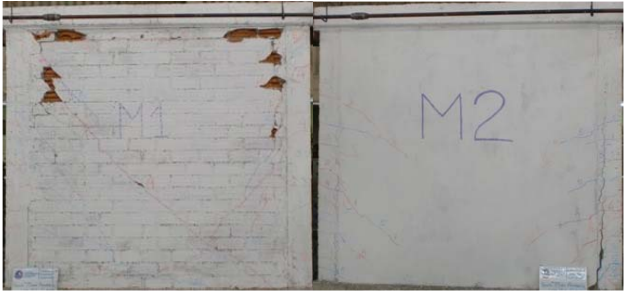
Figura 8.21. Izquierda, Muro Tradicional (M1) – Derecha, Muro enmallado (M2) – Fase 8
