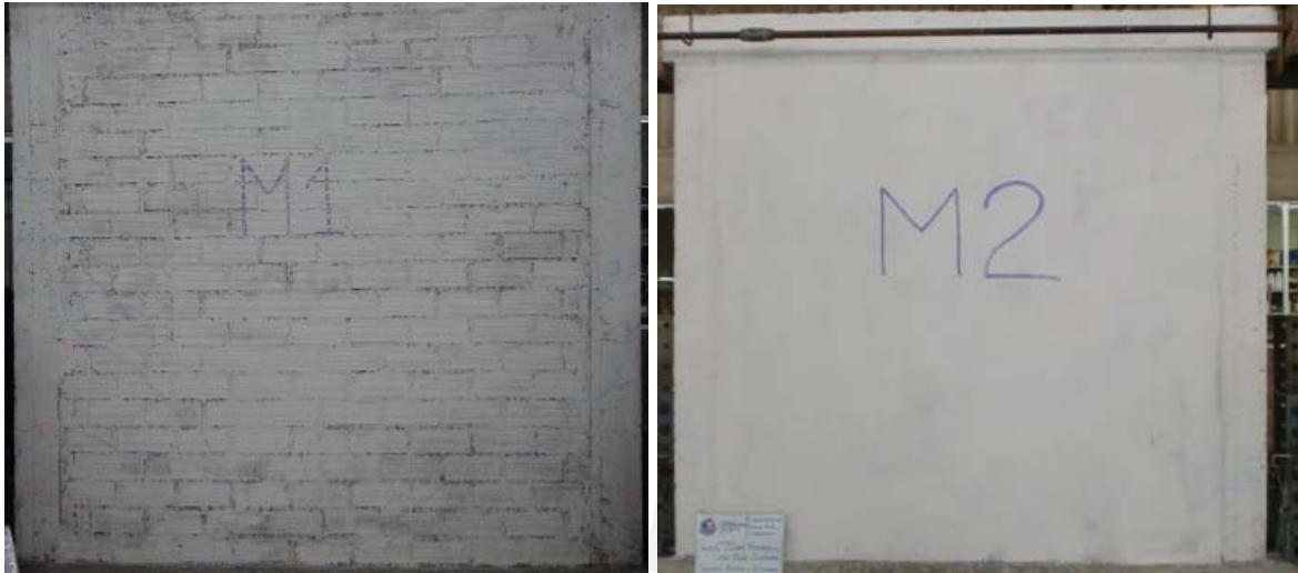
Figura 8.5. Izquierda, Muro Tradicional (M1) – Derecha, Muro enmallado (M2) – Fase 3
