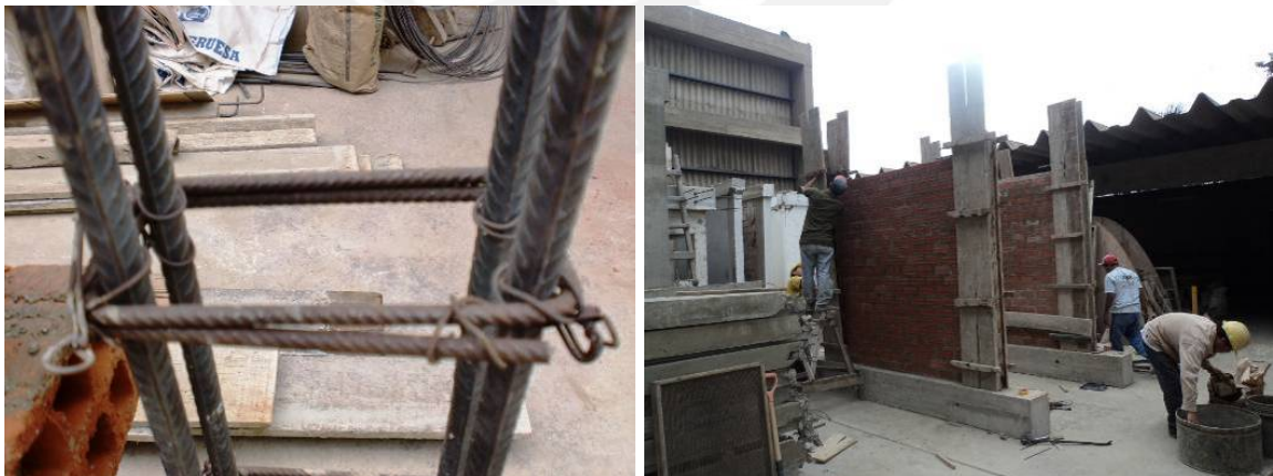
Figura 6.8. Estribos y encofrado de columnas.
