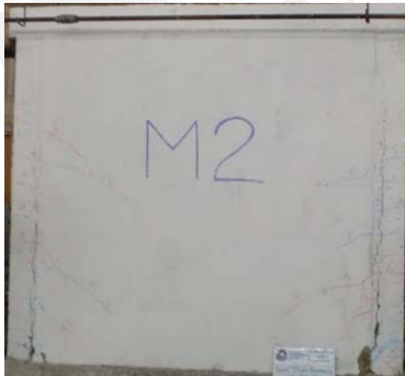
Figura 8.28. Muro enmallado M2 – Fase 10
