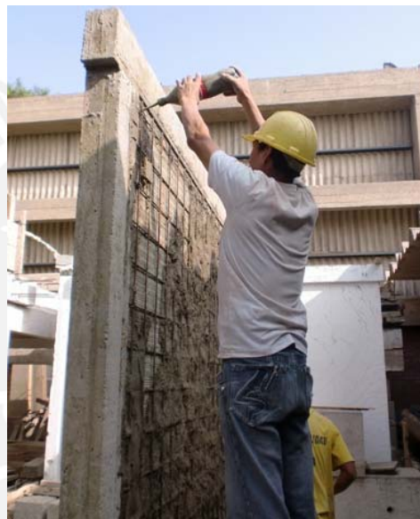
Figura 6.15. Taponado de perforaciones.
