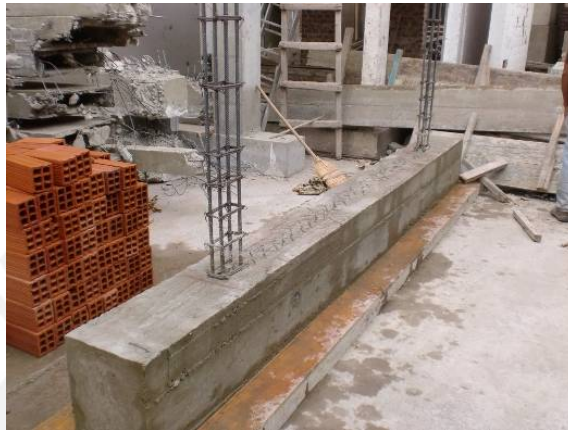
Figura 6.3. Curado de Vigas de Cimentación.
