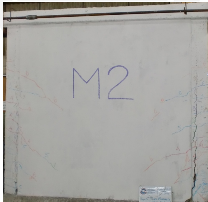
Figura 8.24. Muro enmallado M2 – Fase 9
