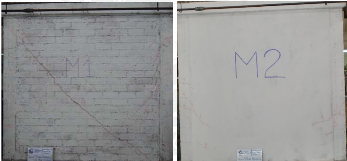
Figura 8.8. Izquierda, Muro Tradicional (M1) – Derecha, Muro enmallado (M2) – Fase 4
