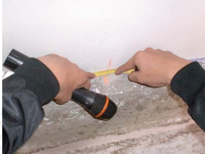
Figura 8.25. Deslizamiento de la albañilería en M2 respecto a la cimentación.
