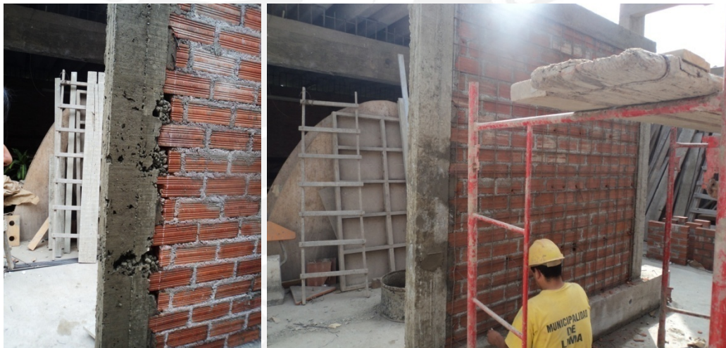
Figura 9.3. Cangrejas en una columna de M2.
