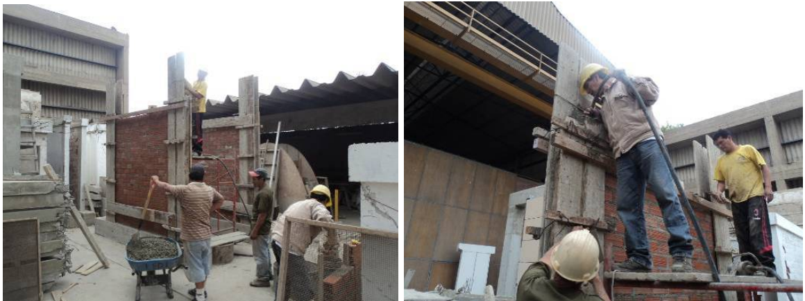
Figura 6.9. Vaciado y vibrado del concreto de columnas.
