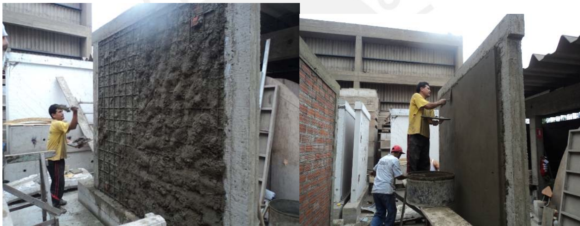
Figura 6.17. Pañeteo del muro y acabado del tarrajeo.
