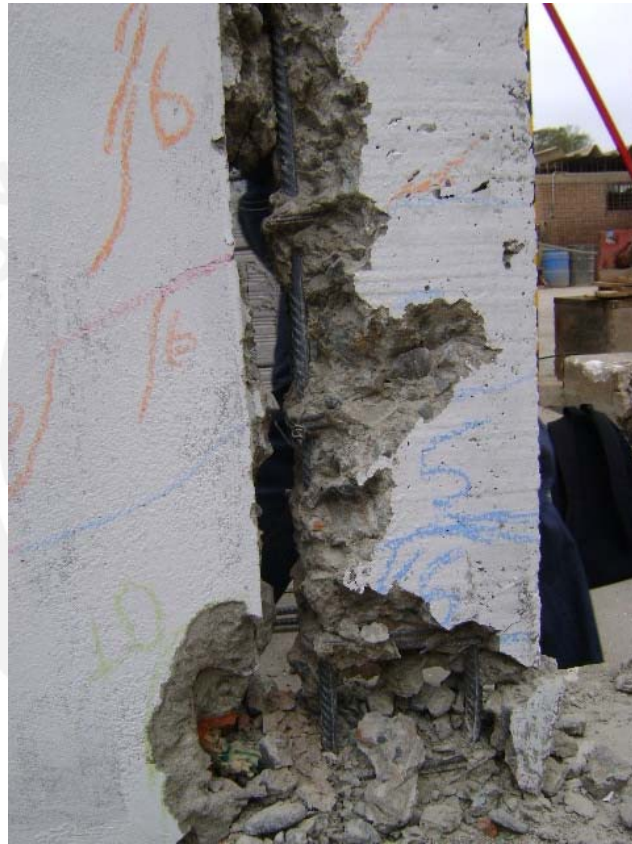
Figura 0.12. Inspección de la columna derecha de M2.
