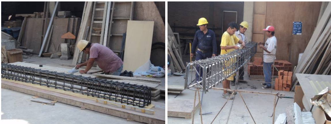
Figura 6.1. Trazo, nivelación y habilitación del acero de la cimentación.
