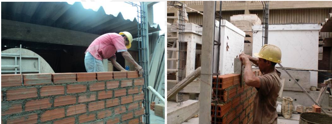
Figura 6.5. Junta de Construcción entre jornadas de trabajo.
