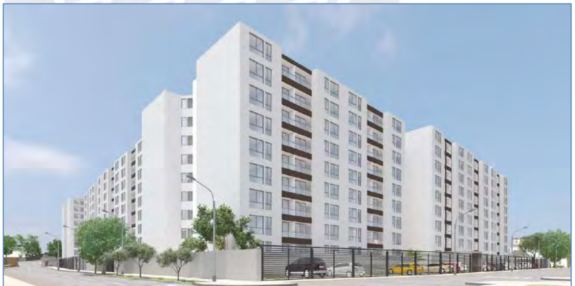
IMAGEN N°49 VISTA REFERENCIAL DE LA FACHADA
