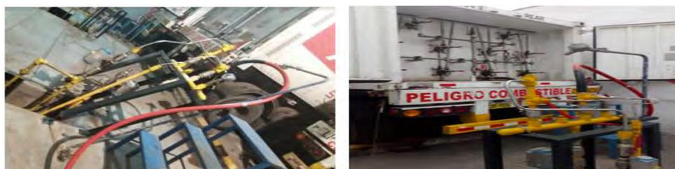
*Figura 56.* Mantenimiento de avería en Zona de Poste de Medición de GNC. Tomado del “Registro de Averías” por Garodi SRL, 2017 Lima, Peru: Archivo enviado por Jefe Flota O. Ponciano (Comunicación Personal, octubre 2017), Lima, Peru.
