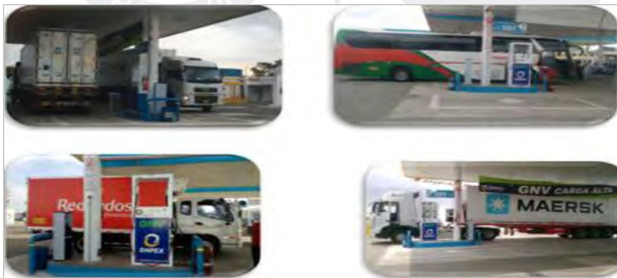
*Figura 52.* Dispensadores de GNV de despacho rápido.
