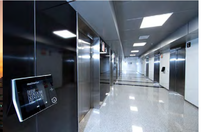
Figura 32 – Ascensores de Torre Orquídeas (Fuente: Adondevivir)
