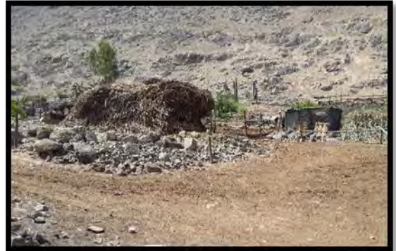
Almacenamiento en estado de precariedad
