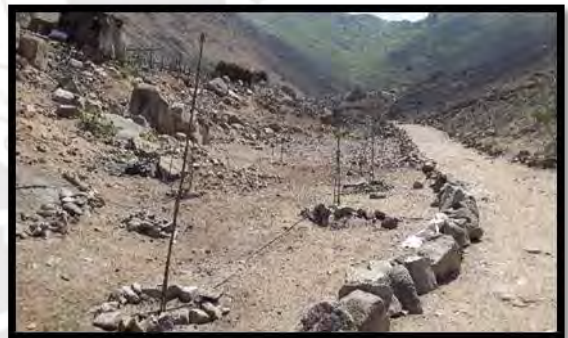
Mangueras distribuidas en plantones
