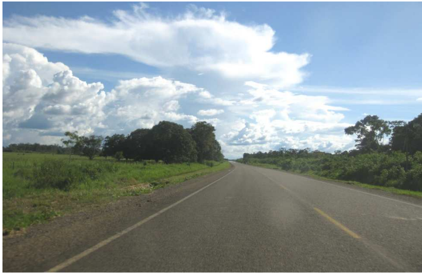
Figura 6: Áreas intervenidas contiguas a la carretera.
