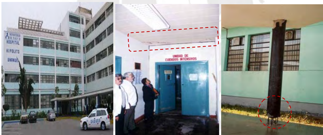
Fig. 2.5: a) Hospital de Tacna. b) Daños en instalaciones sanitarias
