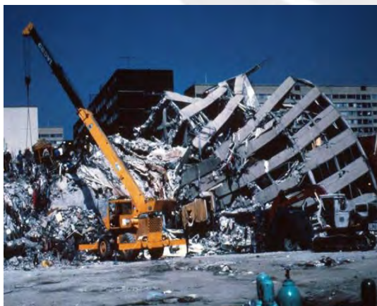
Fig. 2.1: Colapso del Hospital de Juarez, México. Sismo del 19/09/1985
