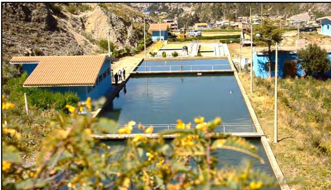
Figura 21. Planta de tratamiento de agua potable.
