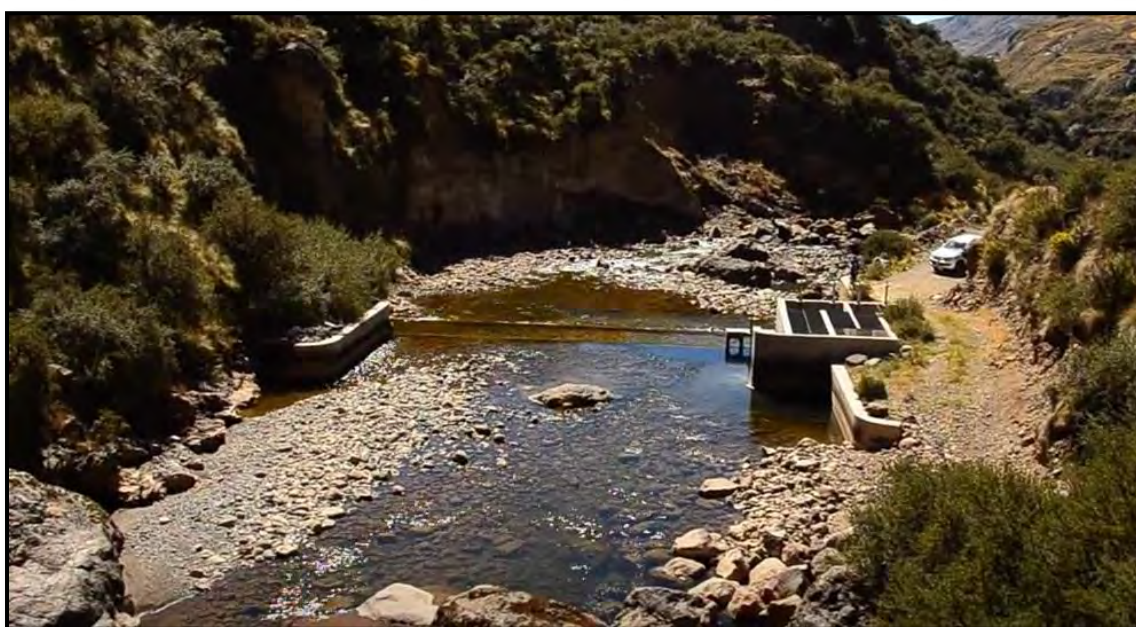
Figura 20. Captación sobre el río Ichu.
