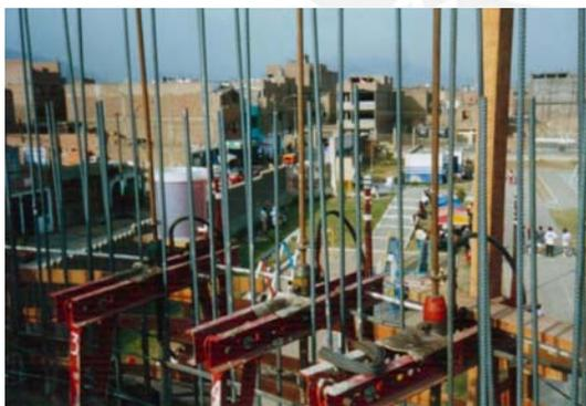
Foto 3.6 Control nivelación horizontal con mangueras
