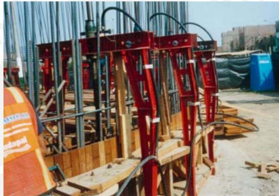
Foto 3.4 Yugos ensamblados a barras de trepar y gatos hidráulicos conectados a mangueras que distribuyen el aceite
