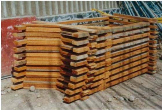
Foto 3.5 Marcos prefabricados para ensamble andamios
