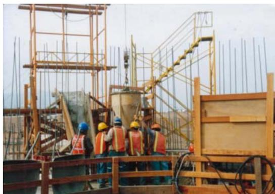
Foto 3.10 Se descarga el concreto sobre la plataforma
