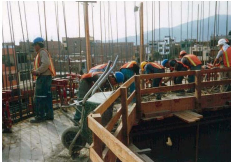
Foto 3.11 El concreto es esparcido dentro del encofrado deslizante
