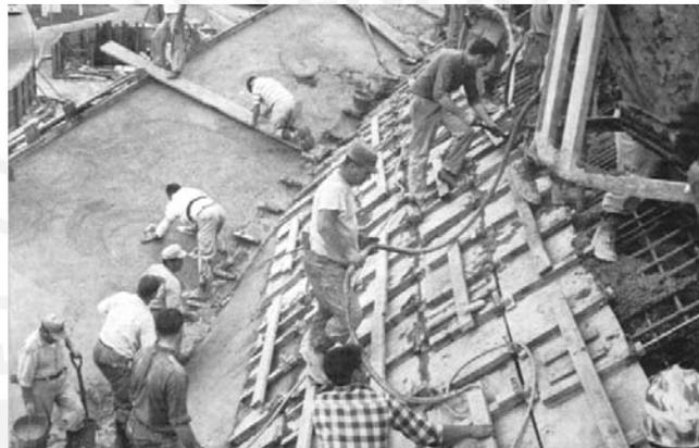
**Foto 2.5 Vaciado de concreto en superficie inclinada**
