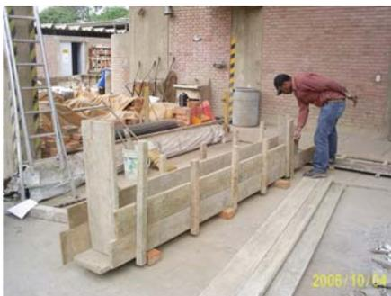
**Foto 5.2** Encofrado de la viga de cimentación
