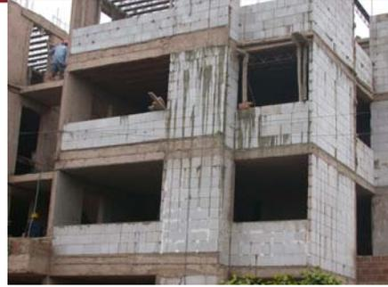
**Foto 1.2** Edificio construido con Placa P-10
