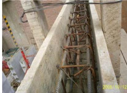
**Foto 5.28** Estructura de acero dentro del encofrado
