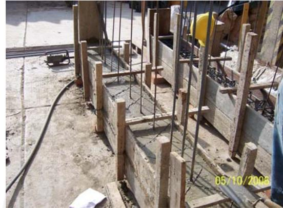
**Foto 5.9** Viga rayada para el asentado del muro
