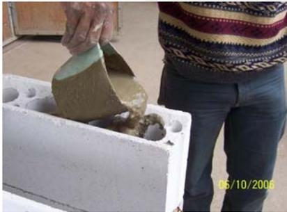
**Foto 4.4** Vaciado a través del alvéolo del extremo
