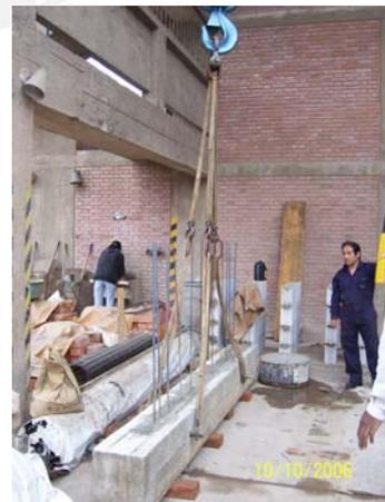
**Foto 5.7** Izaje de la viga a través de los tubos PVC
