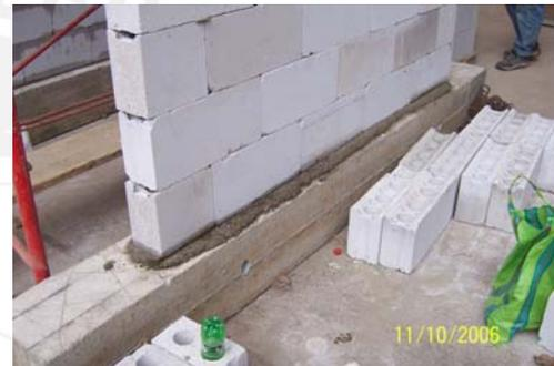
**Foto 5.12 y 5.13** Mortero en la base del muro para su asentado
