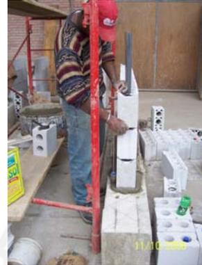
**Foto 5.16** Nivelación del muro
