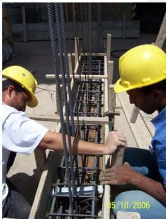
**Foto 5.6** Colocación de los tubos PVC
