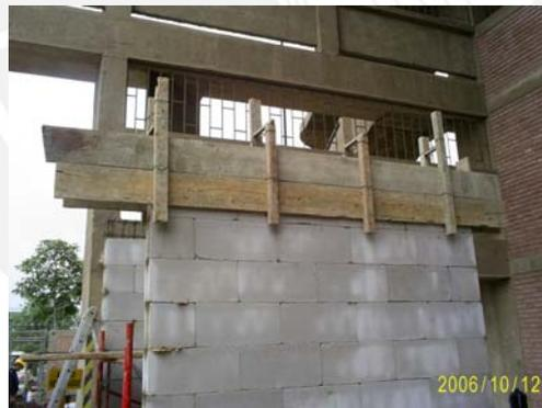
**Foto 5.26** Encofrado de la solera
