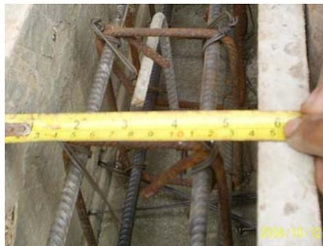
**Foto 5.27** Comprobación del espesor de la viga
