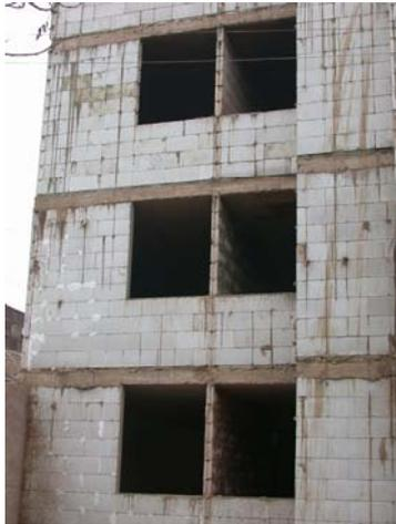
**Foto 1.3** Unión simple entre muros sin
