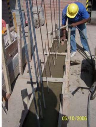
**Foto 5.8** Vaciado de concreto
