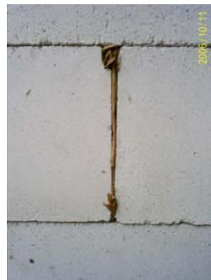
**Foto 5.20, 5.21, 5.22 y 5.23** Huecos tapados para evitar que el concreto líquido se salga.
