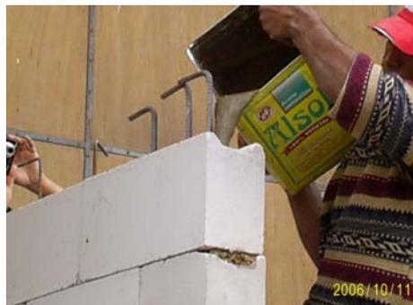
**Foto 5.25** Vaciado del grout
