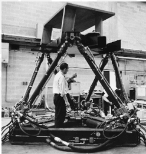
Figura 1.1: Simulador de movimiento de Klaus Cappel. Construido durante los años sesenta.
