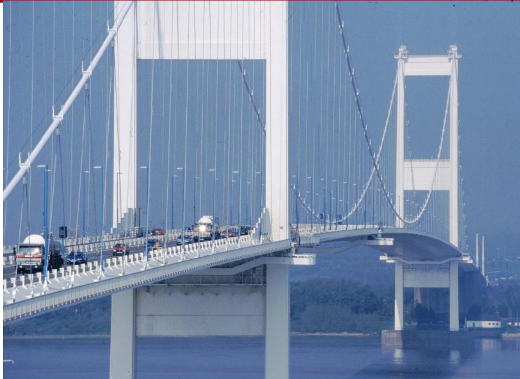
Puente colgante Severn, Inglaterra, 1966 – Figura 1.5
