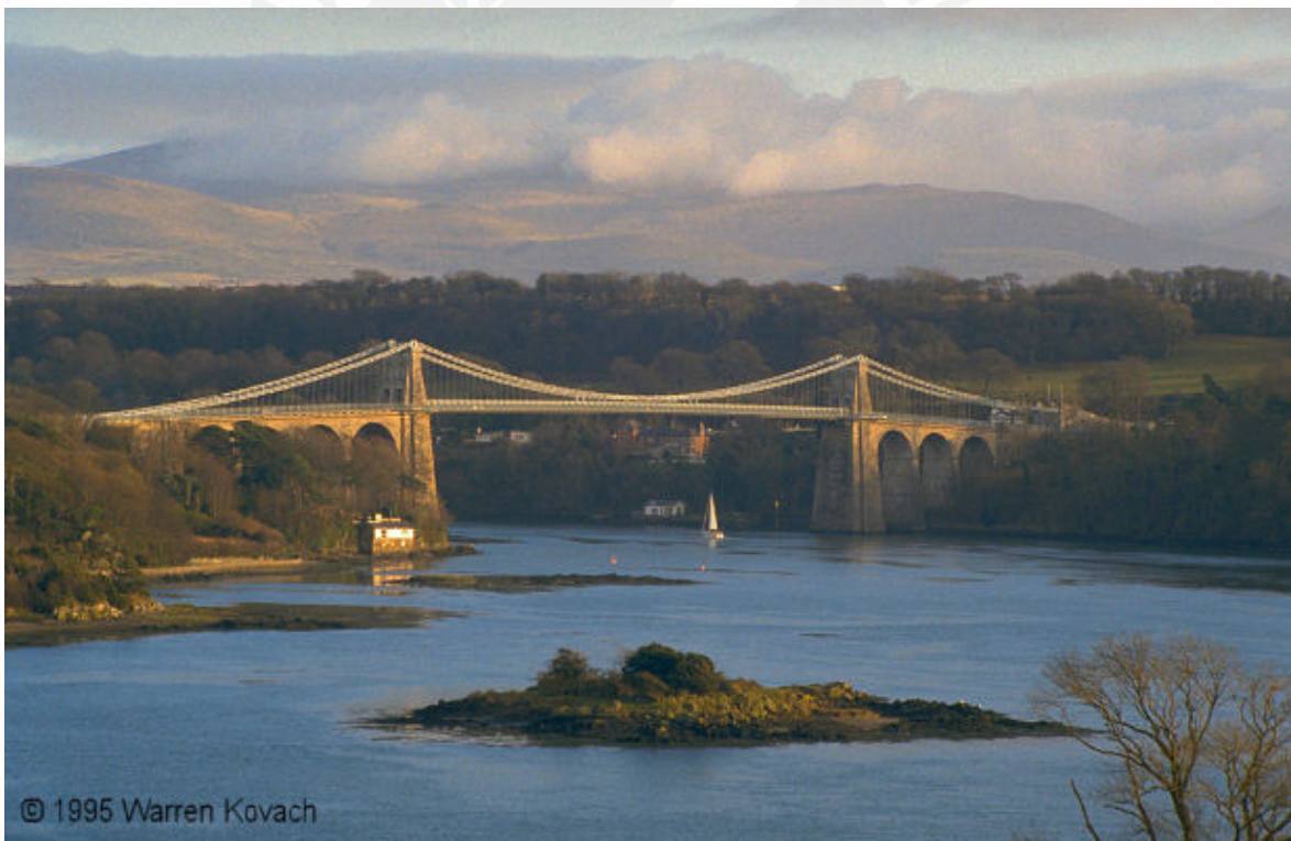
Puente colgante del Menai, Gales, 1826 – Figura 1.2
