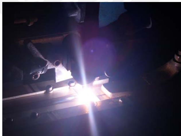
Figura 2.7 Proceso de soldeo de las planchas de acero inoxidable dúplex S2304
