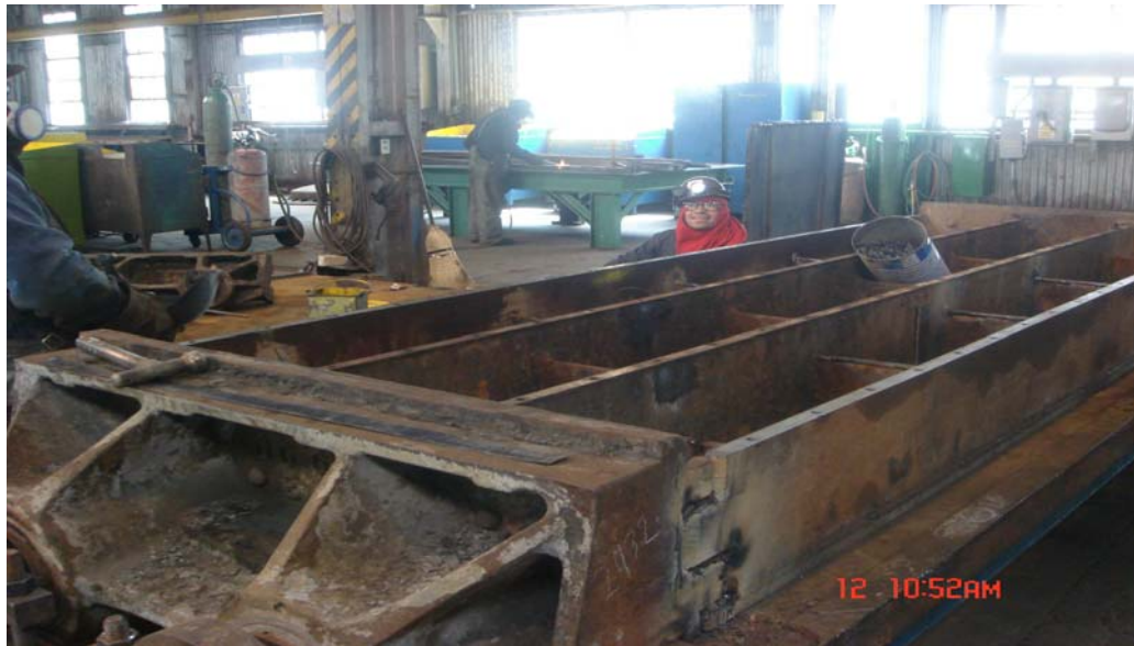
Foto 3.4: Verificación de espesores, de la estructura del carro sinter, en el Taller Estructural
