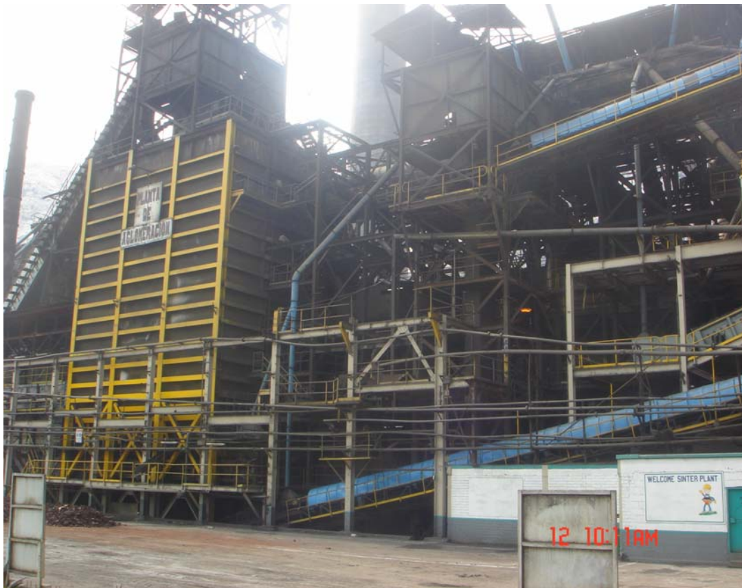
Foto 2.2: Planta de aglomeración, La máquina principal de la planta es la 2051, provista en toda su longitud de 142 carros sinter.
