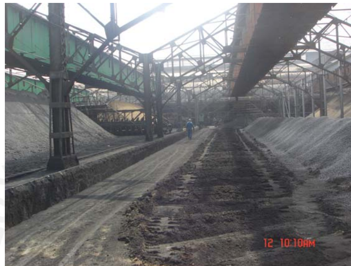
Foto 2.2A: Camas de concentrado de plomo que alimenta a la planta de aglomeración mediante reclamadoras.
