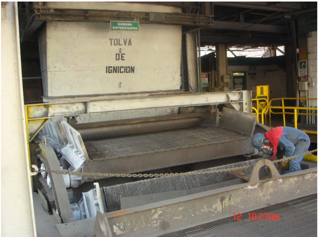
Foto 2.7: Verificación de la linealidad de los carros sinter, para su óptima operación.
