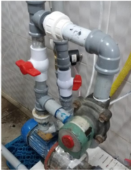
Figura 4.7: Fotografía de la distribución de electroválvulas.
