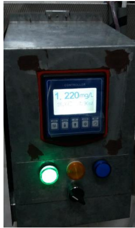
Figura 4.18: Estado inicial del tablero.
