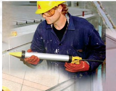
Figura 9. Pistola para la inyección en fisuras (Fuente: Sika Argentina S.A.I.C.).
