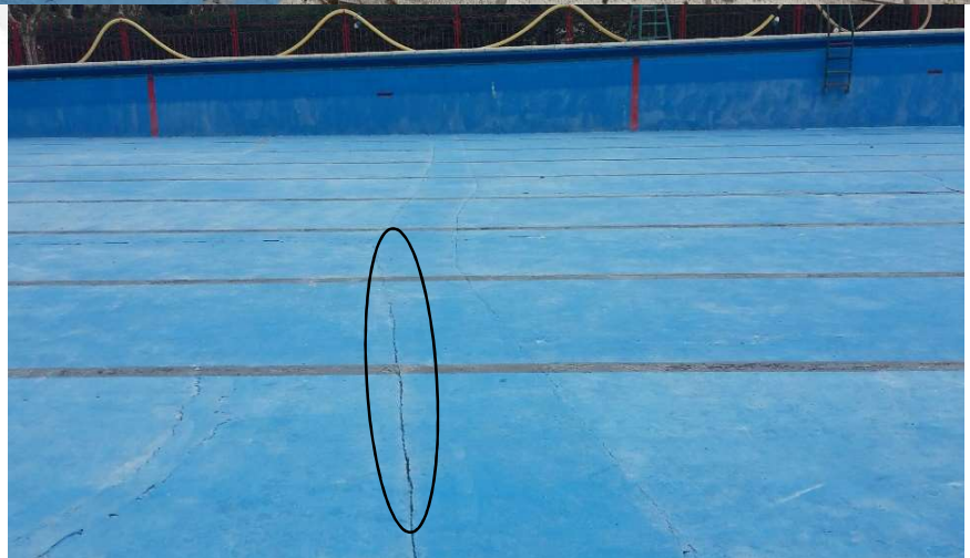
Figura 26. Pileta del sindicato del seguro argentino en C.A.B.A. (Fuente Sika Argentina S.A.I.C).
