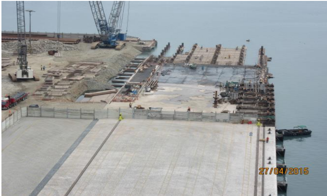
Figura 11: Vista uno de la Ampliación del muelle 5 del TMN del Callao
