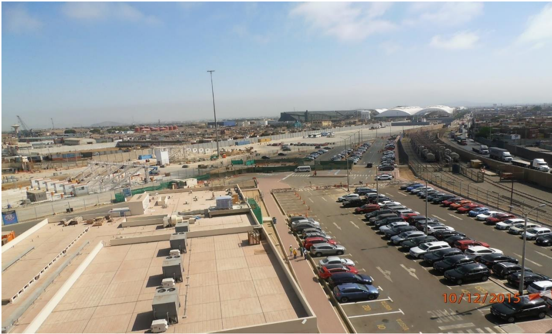
Figura 10: Vista aérea tres de habilitaciones urbanas del TMN del Callao
