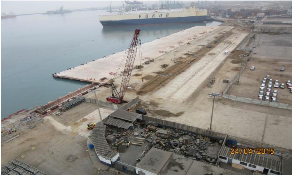
Figura 13: Vista uno de la ampliación del muelle 11 del TMN del Callao
