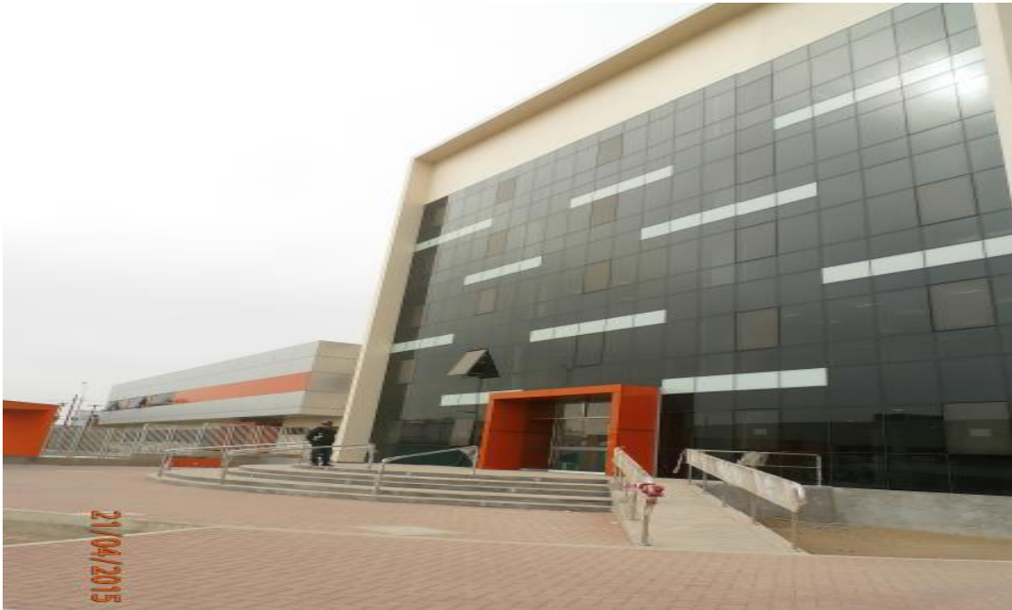
Figura 5: Edificio administrativo del TMN del Callao
