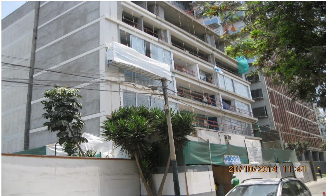
Figura 1: Vista lateral del edificio Clement en proceso de construcción
