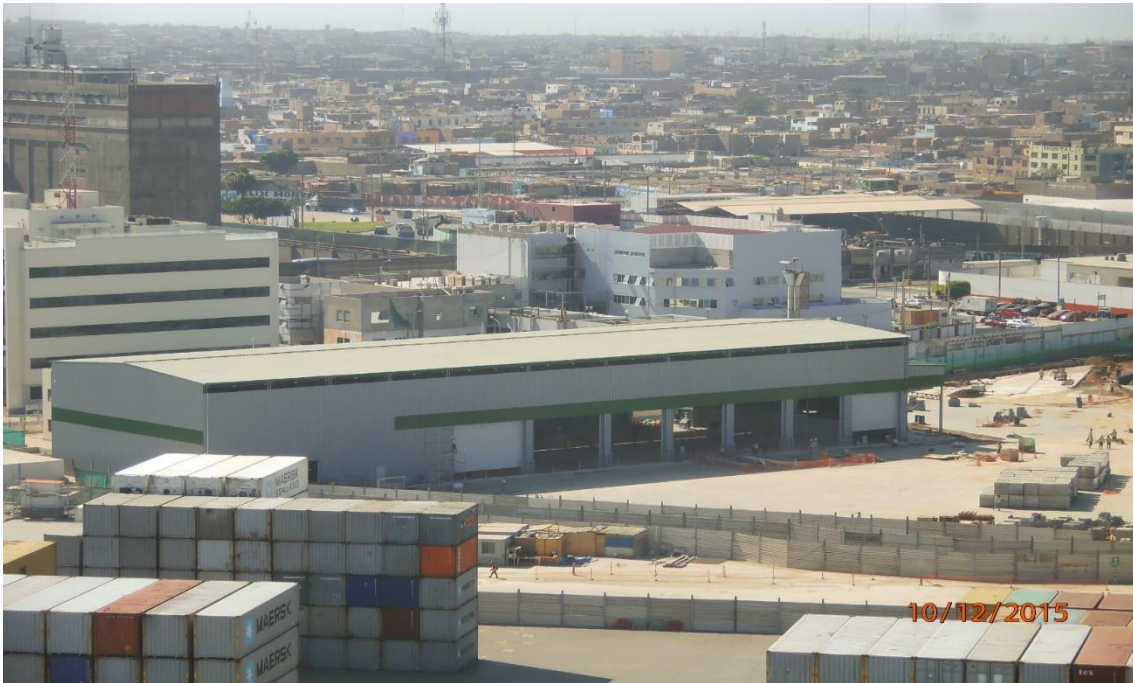
Figura 7: Taller de mantenimiento
