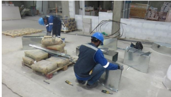
Ilustración 79 Proceso de instalación. Fuente: Propia.
