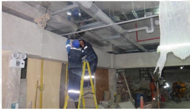
Ilustración 77 Proceso de instalación de ducto de extracción. Fuente. Propia.
