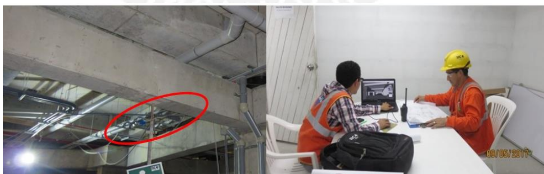
Ilustración 67 Reunión de coordinación con instalador de instalaciones sanitarias. Fuente: Propia.
