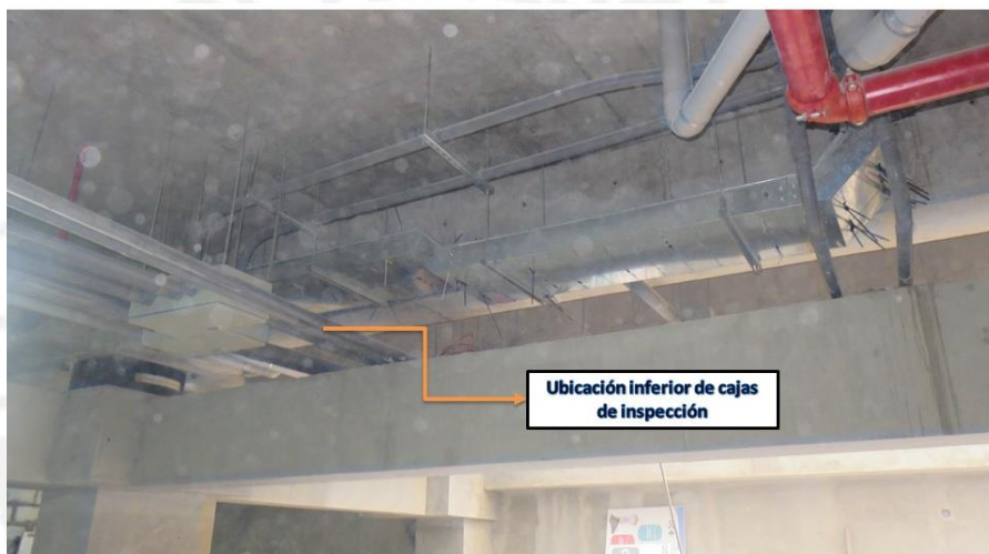
Ilustración 66 Emplazamiento en campo de cajas de pase de instalaciones de comunicaciones. Fuente: Propia.
