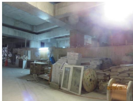
Ilustración 60 Almacén de obra. Fuente: Propia.
