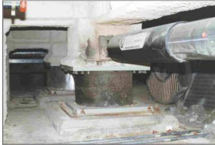
Figura 3.5. Aislador LDRB conectado a un amortiguador (Symans)
