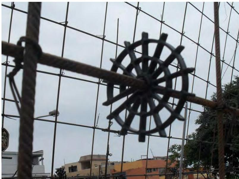
Fig. 2.25: Acercamiento de un separador prefabricado. Se colocan de manera vertical para permitir la circulación del concreto.
