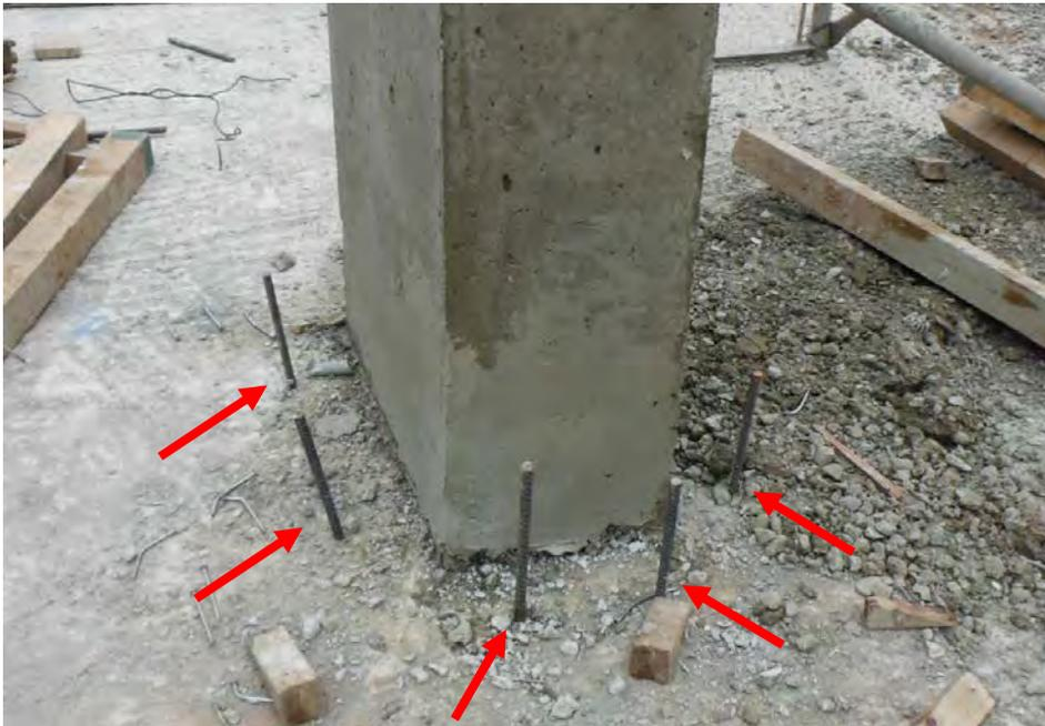
Fig. 2.45: Columna desencofrada, y las barras de acero de la figura 2.44 sin causar repercusión en el elemento estructural.
