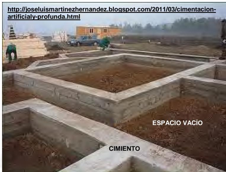
Fig. 1.18: Típico escenario, en el que los espacios entre los cimientos deben ser completados con material de relleno.
