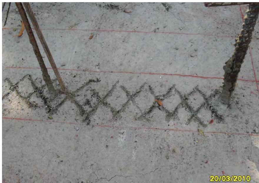
Fig. 2.33: Preparación de la losa de concreto en la zona receptora del elemento vertical. Se aumenta la rugosidad de la superficie.
