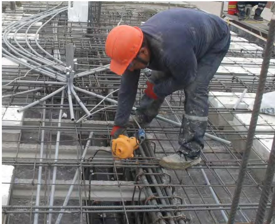
*Fig. 2.32: Limpieza del encofrado de una losa antes del vaciado, mediante la inyección de aire a presión.*
