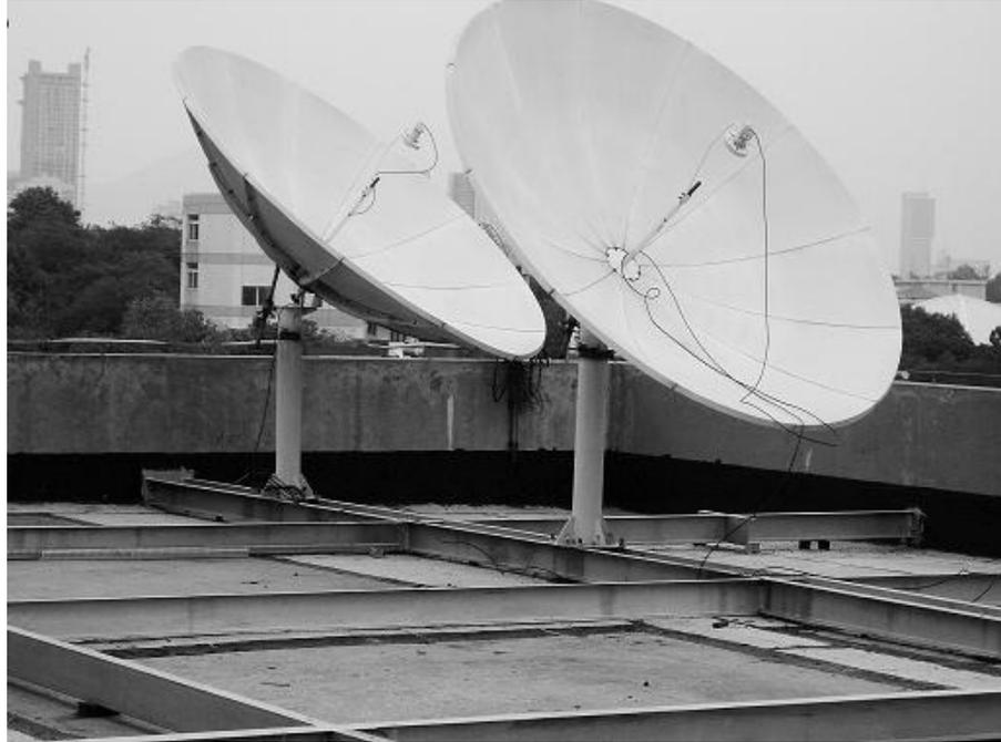
*Figura 1.1 Antena para TVRO de la empresa Probecom*
