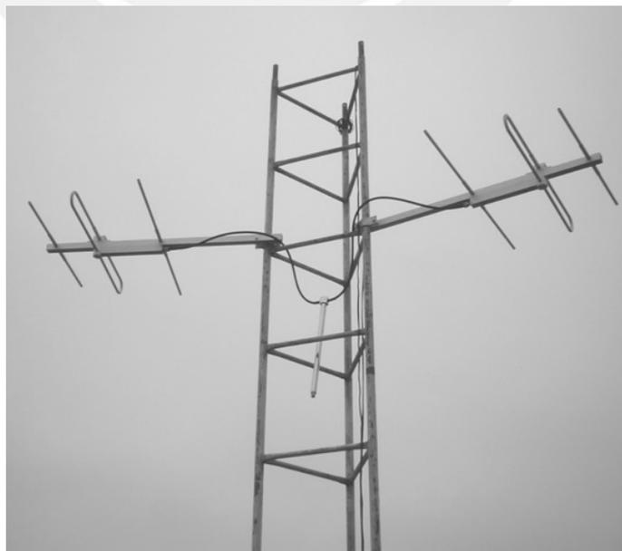
*Figura 1.4 Antena de radiodifusión tipo yagui de la empresa Laprotel*
