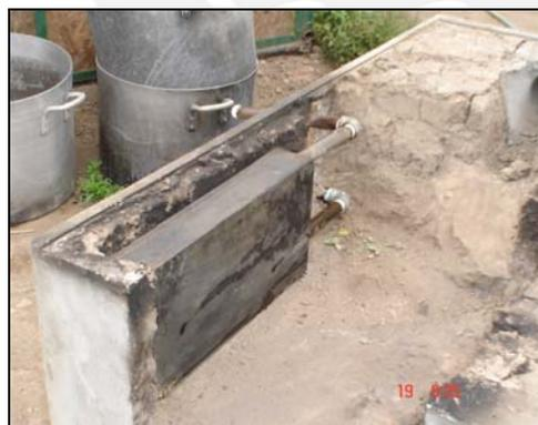
**MONTAJE DEL INTER. DE CALOR EN LA COCINA
